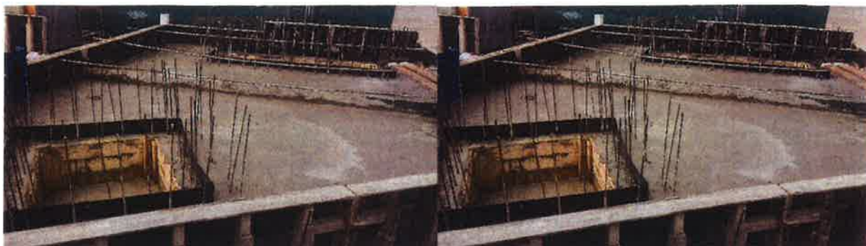
Těsnění prostupů stropu
