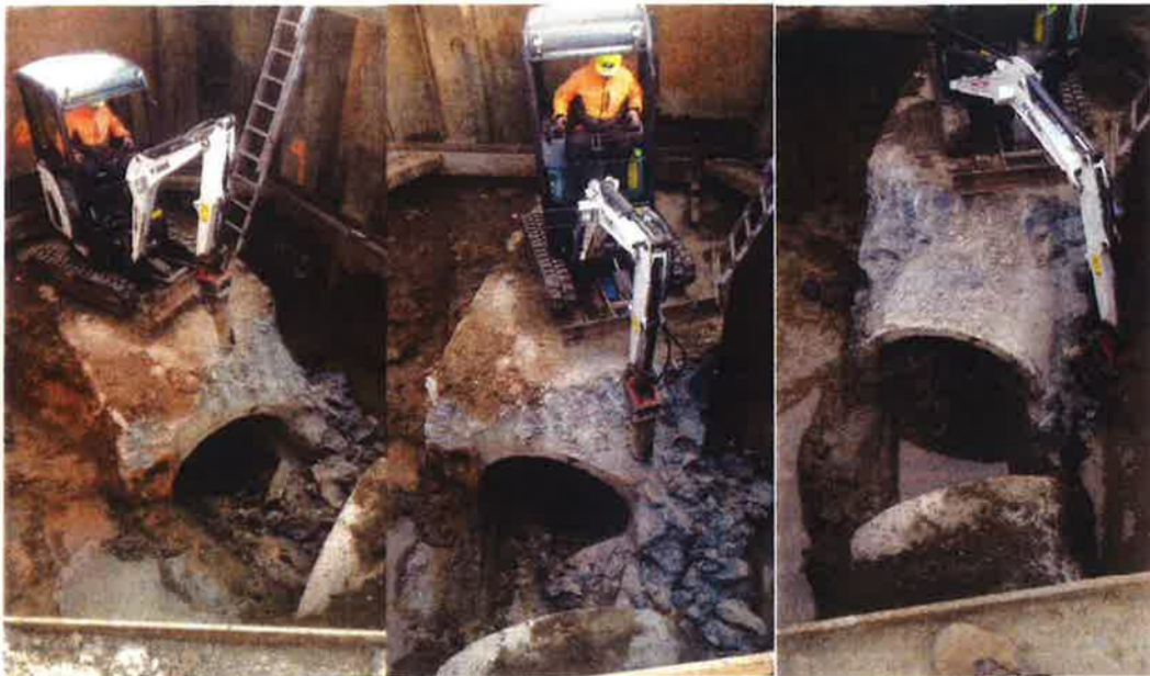
Odbourávání obetonování potrubí
