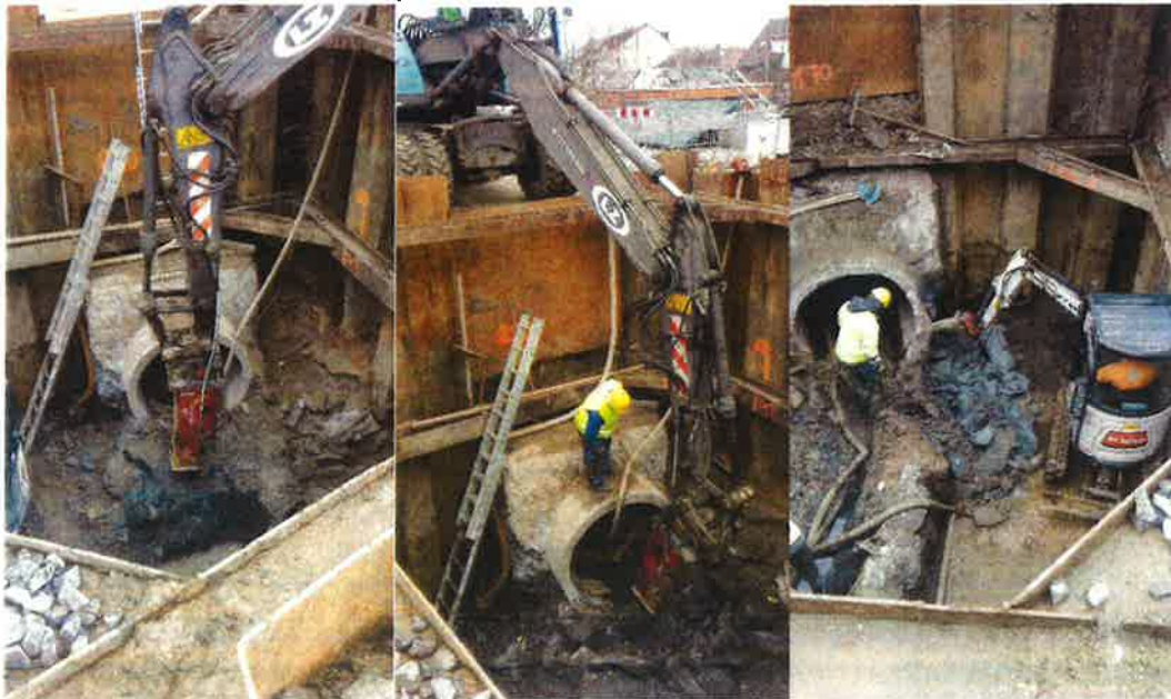
Odbourávání obetonování potrubí
