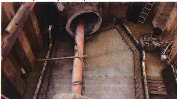
Těsnění stěn a stropu
