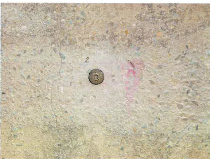
Zkušební místo číslo 2 pro stanovení soudržnosti povrchových vrstev betonu a nedestruktivní stanovení pevnosti betonu
