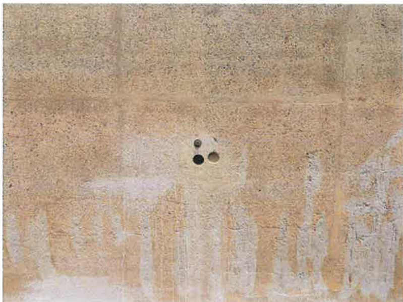
Místo odběru zkušebního vzorku číslo 1 pro stanovení pevnosti betonu
