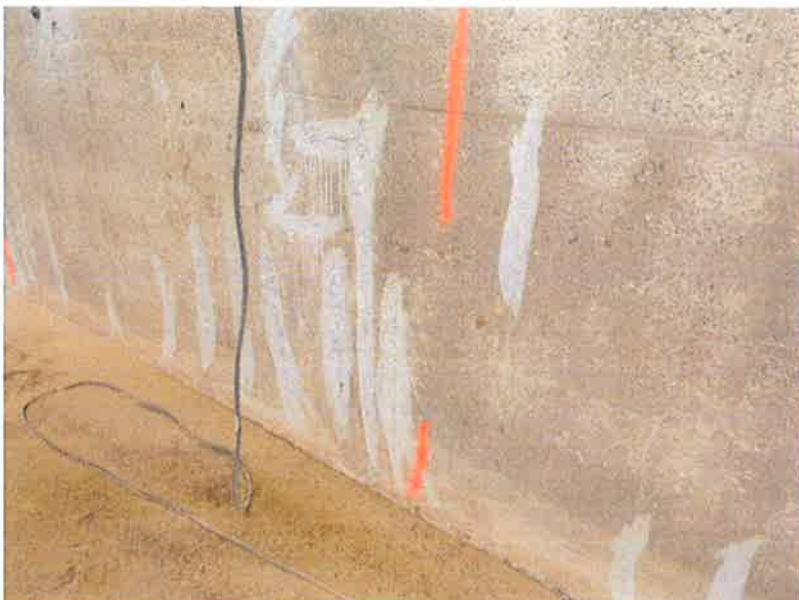
Odhalené a ošetřené výztuže stěny nádrže
