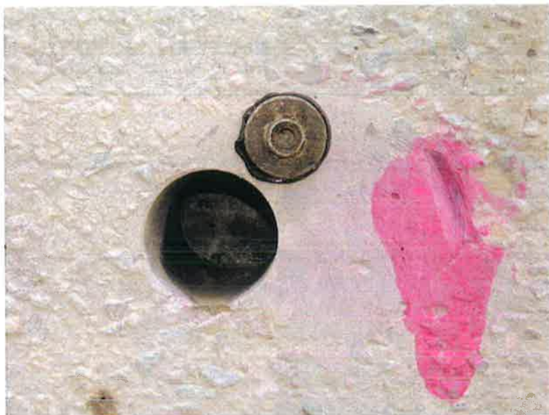
Zkušební místo číslo 1 pro stanovení soudržnosti povrchových vrstev betonu a nedestruktivní stanovení pevnosti betonu
