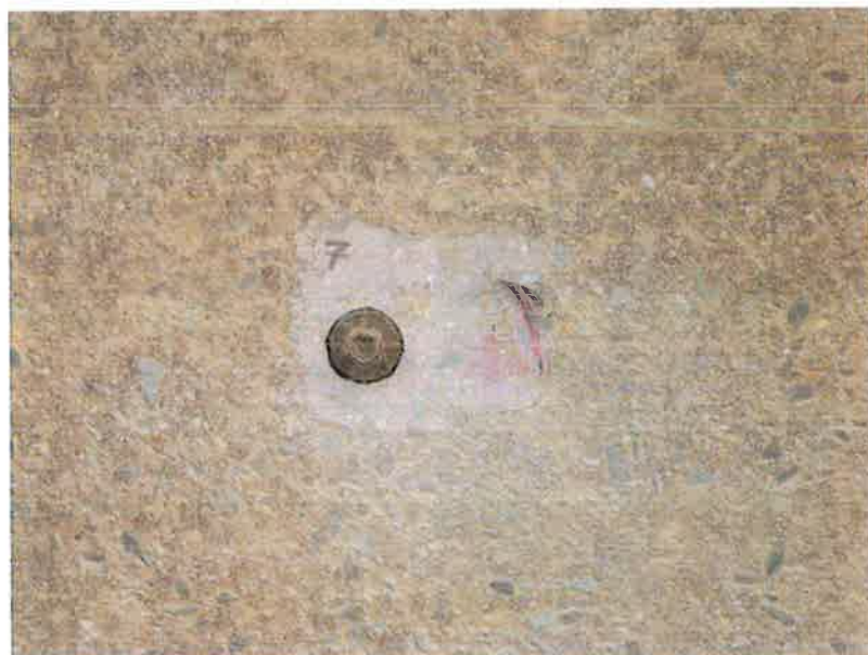
Zkušební místo číslo 7 pro stanovení soudržnosti povrchových vrstev betonu a nedestruktivní stanovení pevnosti betonu
