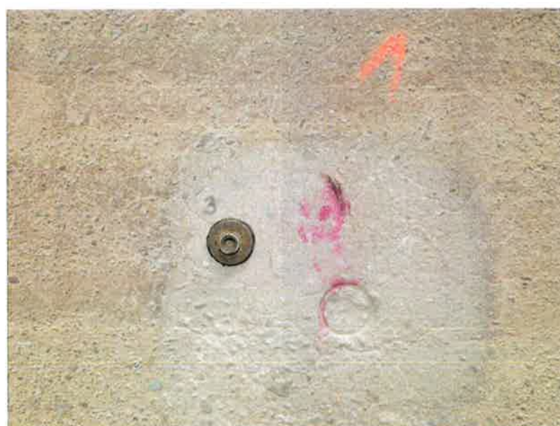
Zkušební místo číslo 3 pro stanovení soudržnosti povrchových vrstev a nedestruktivní stanovení pevnosti betonu
