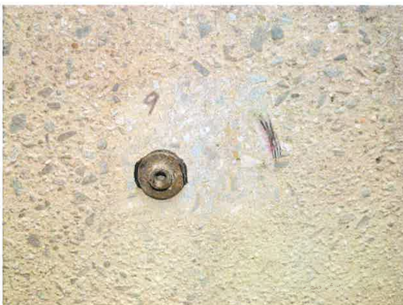
Zkušební místo číslo 9 pro stanovení soudržnosti povrchových vrstev a nedestruktivní stanovení pevnosti betonu
