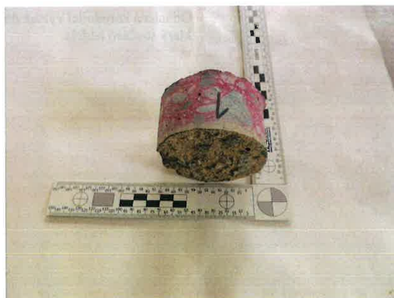
Karbonatace betonu provedená na odebraném vzorku k výztuži stěny nádrže
