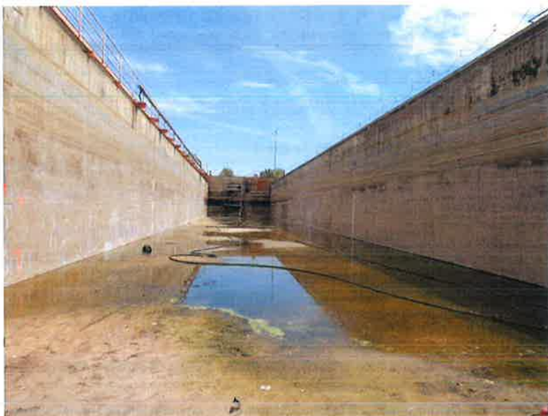
Pohled na ohledávanou nádrž AN 13
