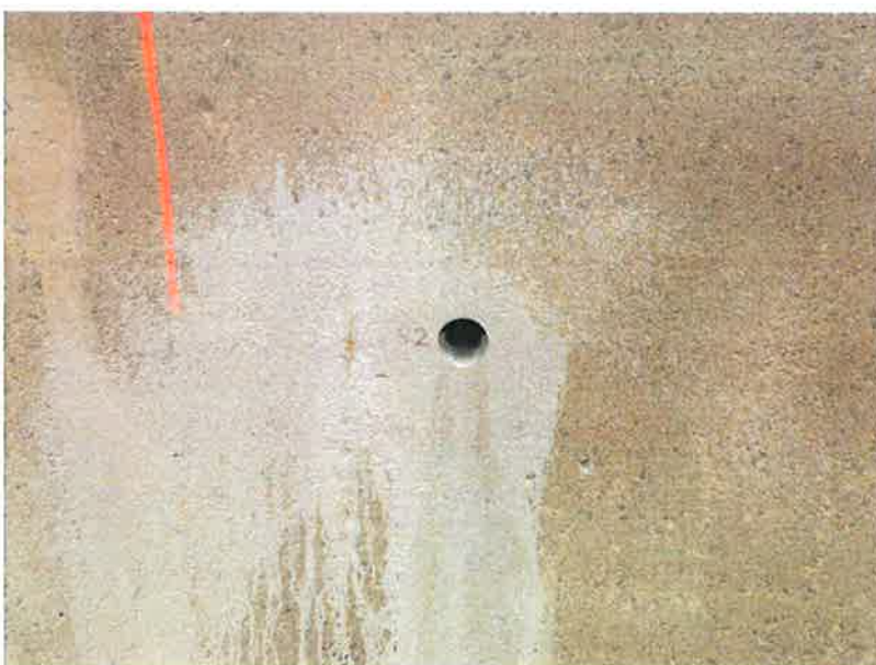
Místo odběru zkušební vzorku číslo 2 pro stanovení pevnosti betonu
