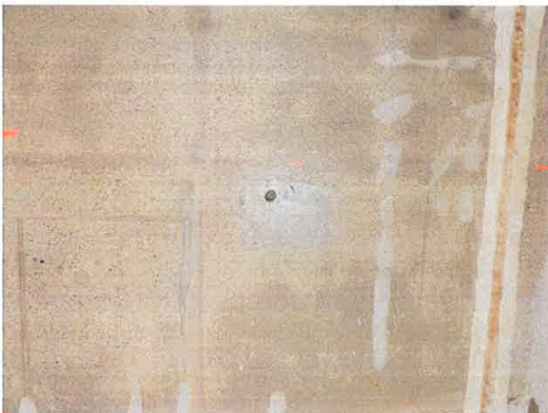
Zkušební místo číslo 4 pro stanovení soudržnosti povrchových vrstev a nedestruktivní stanovení pevnosti betonu
