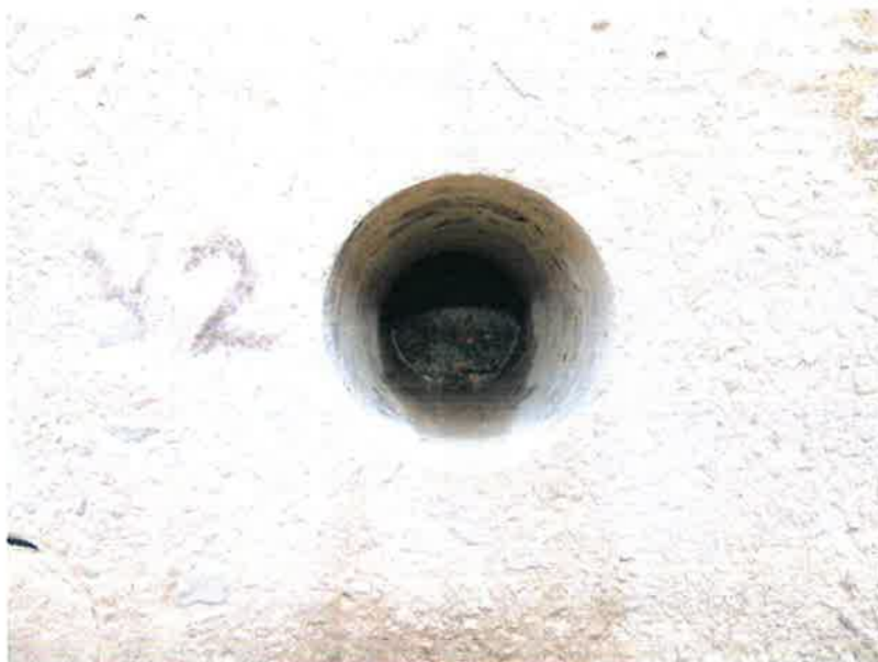
Pohled do otvoru po odběru vzorku betonu
