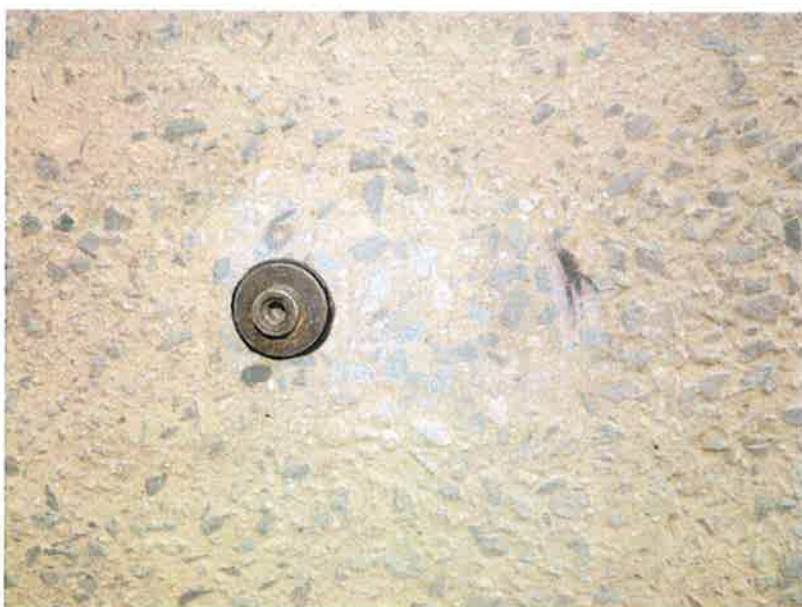
Zkušební místo číslo 6 pro stanovení soudržnosti povrchových vrstev betonu a nedestruktivní stanovení pevnosti betonu
