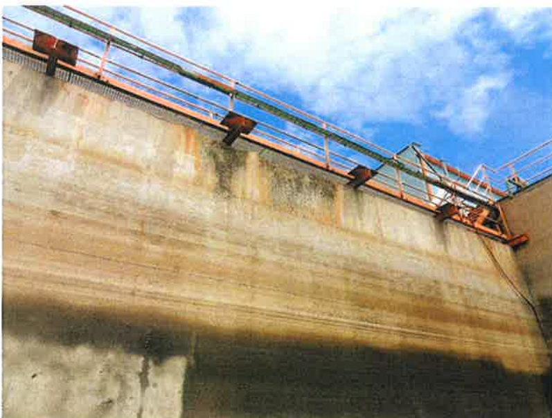
Pohled na část stěn nádrže před otryskáním
