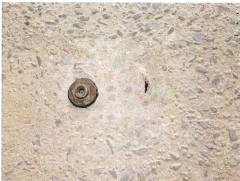
Zkušební místo číslo 5 pro stanovení soudržnosti povrchových vrstev betonu a nedestruktivní stanovení pevnosti betonu
