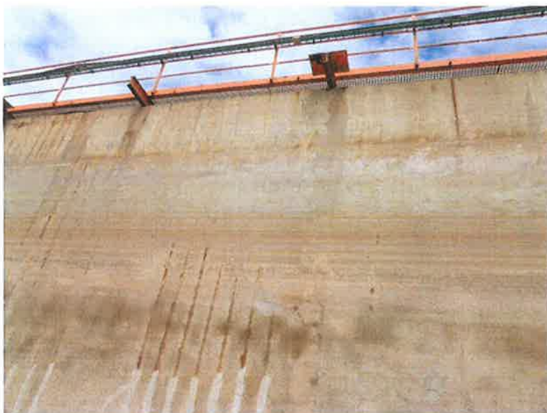
Odhalené a ošetřené výztuže stěny nádrže
