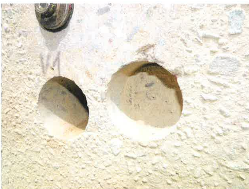
Pohled do otvoru po odběru vzorku k výztuži stěny nádrže
