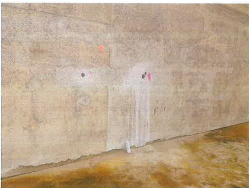
Pohled na část stěny nádrže se zkušebními místy číslo 1 a 2, místo odběru zkušebního vzorku
