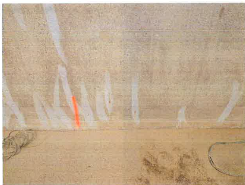
Odhalené a ošetřené výztuže stěny nádrže
