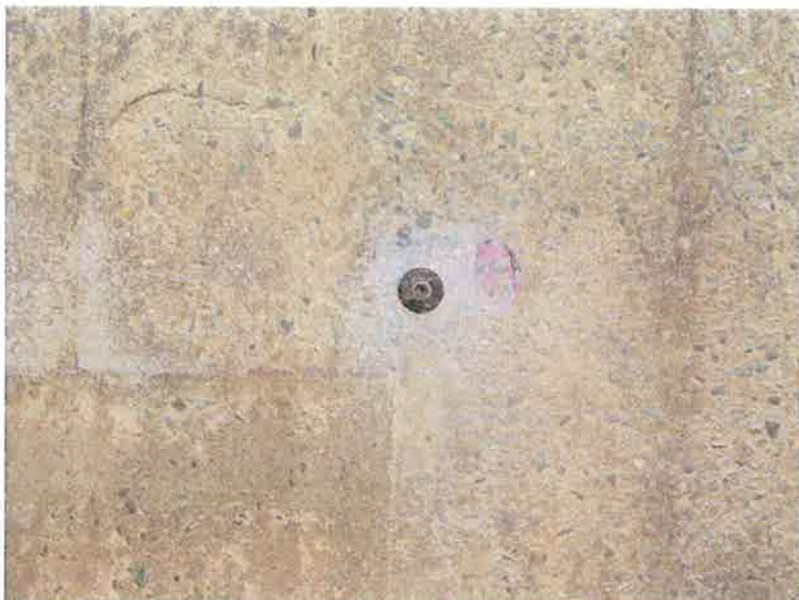
Zkušební místo číslo 8 pro stanovení soudržnosti povrchových vrstev betonu a nedestruktivní stanovení pevnosti betonu
