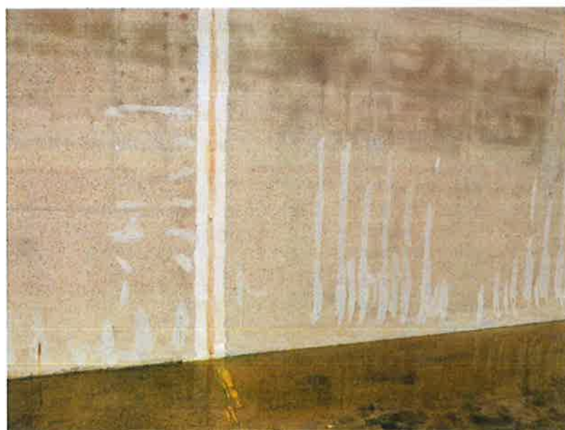
Odhalené a ošetřené výztuže stěny nádrže
