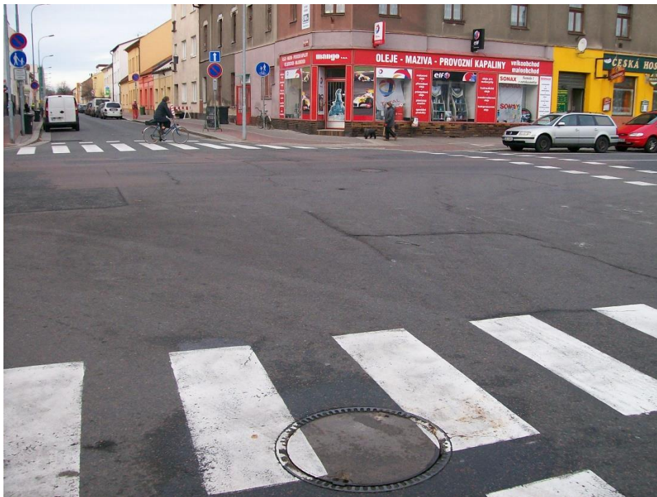
Obr. 3 Stav poklopu šachty (ID S0122501) pro systém KIS-KDT
