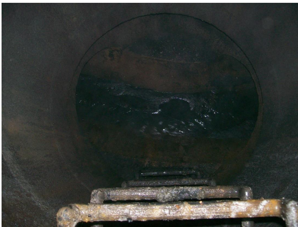
Obr. 4 Vnitřní technický stav šachty (ID S0122501) vkládané do systému KIS-KDT
